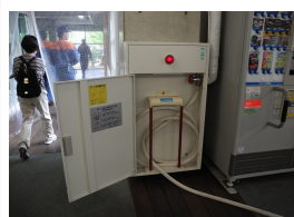
1階自販機横の消火 栓ボックス (各階にもあります)
